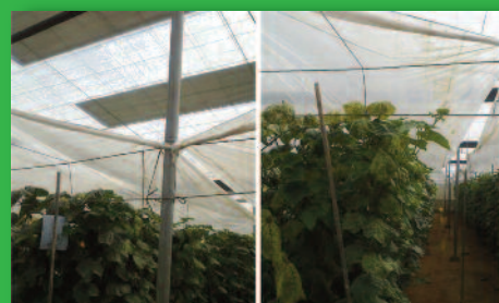
Nuevo diseño de invernaderos con integración de módulos fotovoltaicos
